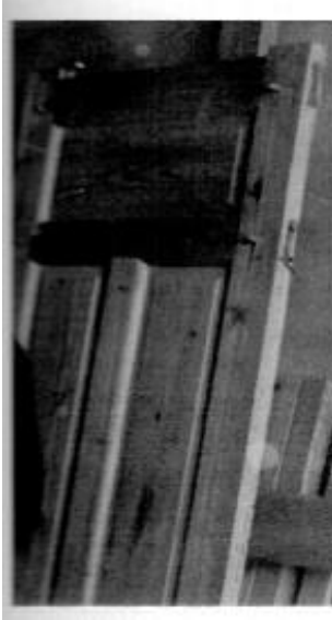
Φωτογραφία 1957. Πόρτα μονταρισμένη-κολλημένη πριν κοπούν καβύλιες και σφήνες.
