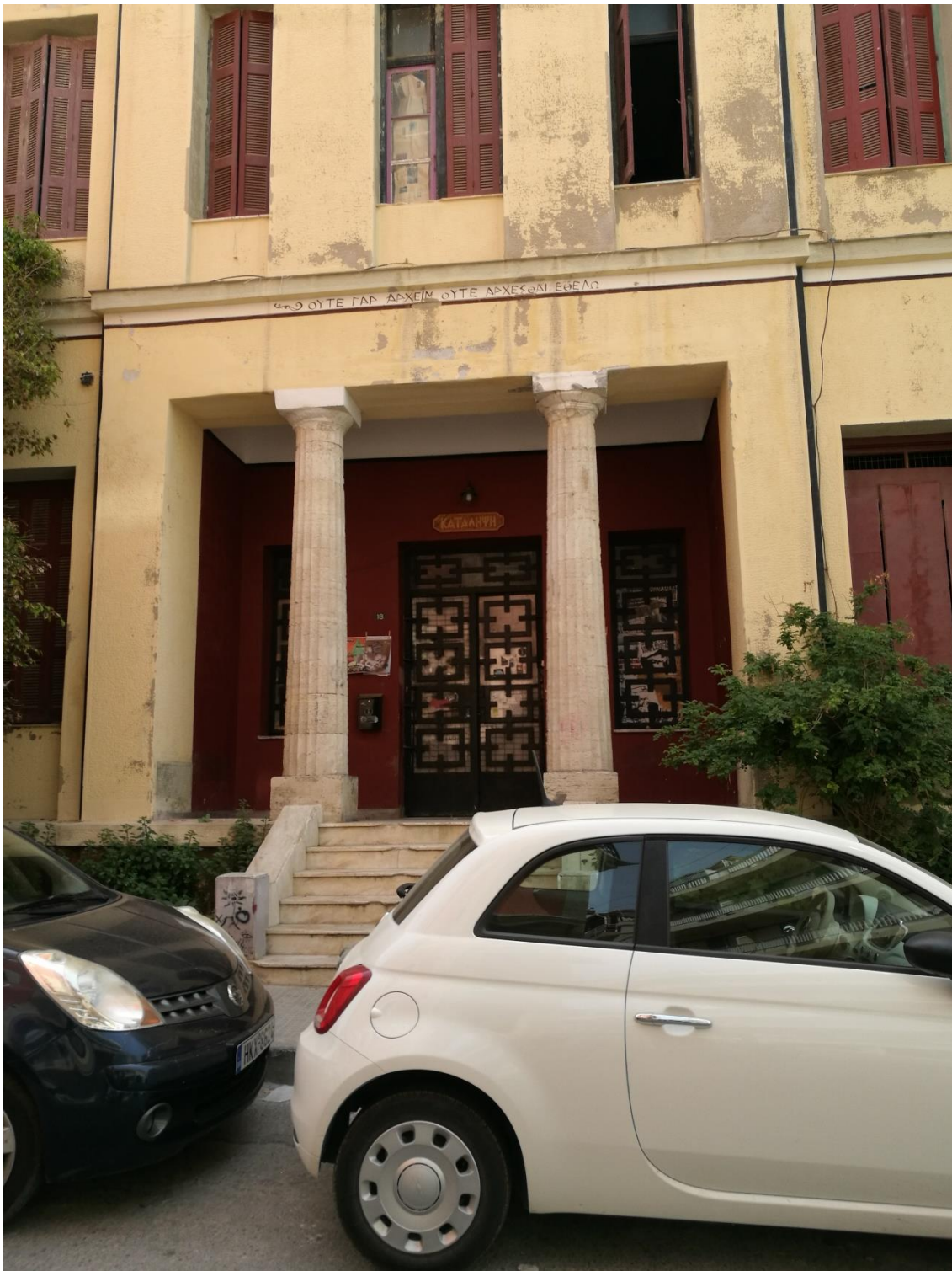
Το κτίριο του παλιού νοσοκομείου «Ευαγγελισμός» και νυν κατάληψη.
