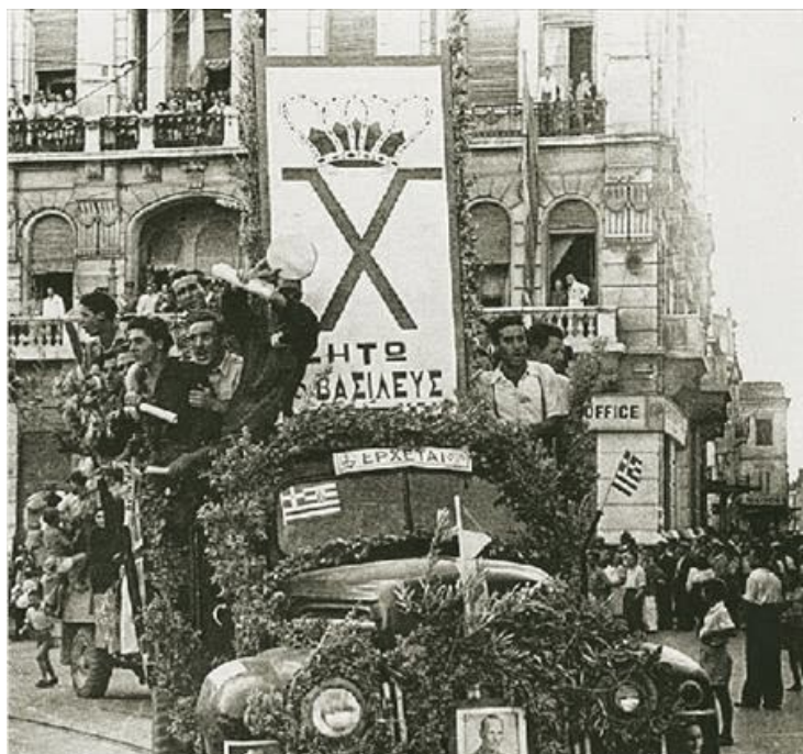
Υποστηρικτές της «X» λίγο μετά την απελευθέρωση της Αθήνας.
