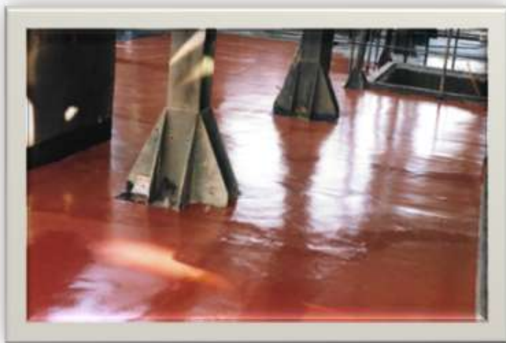
Κατασκευή αντιολησθηρού δαπέδου στο εργοστάσιο της Δ.Ε.Η. ΑΗΣ Αλιβερίου στον Κάραβο
