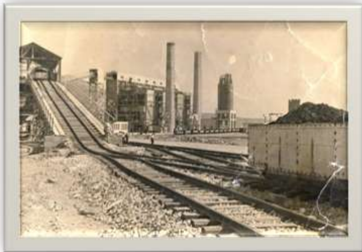
Βαγόνια με λιγνίτη από το λιγνιτωρυχείο Αγίου Λουκά, φτάνουν στον σπαστήρα του εργοστασίου ηλεκτροπαραγωγής.
