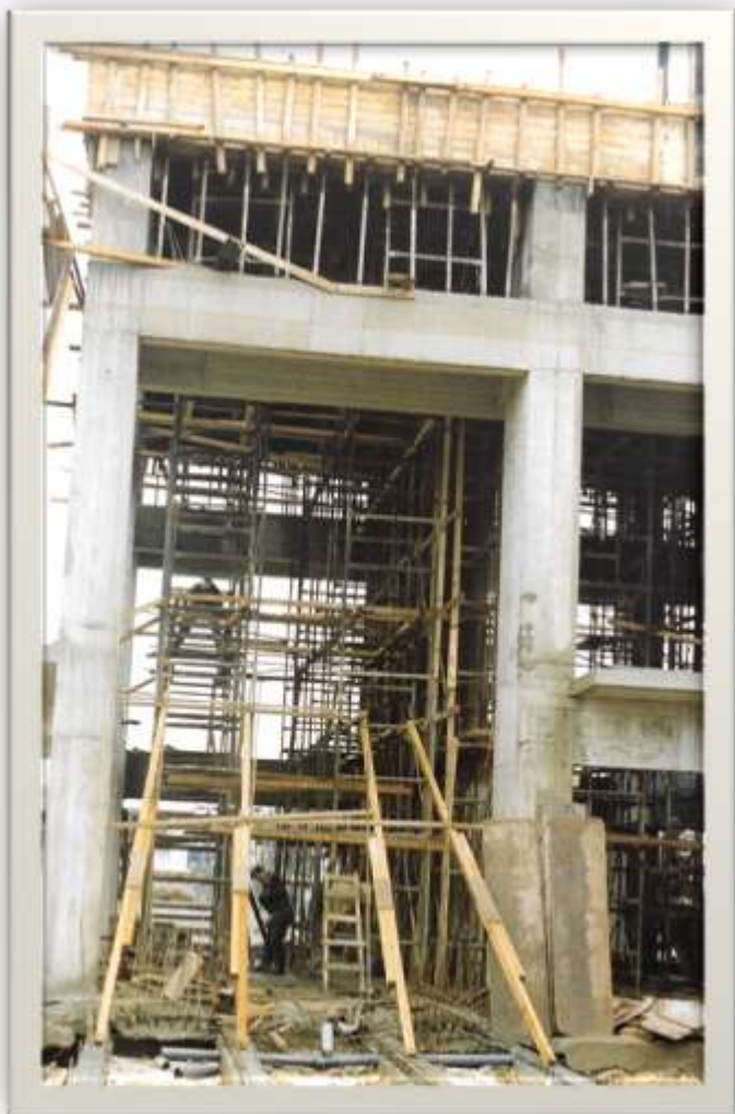
Κατασκευή κτιρίου επισκευής μετασχηματιστών στη Λάρισα, 1998
