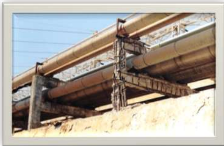
Επισκευή υποστηλωμάτων στο εργοστάσιο της Δ.Ε.Η. Λαυρίου (Υπάρχουσα κατάσταση)
