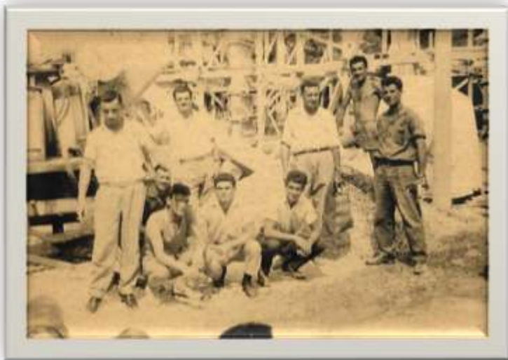
κατασκευή του σπιτιού στην οδό Λαμπάκη, Αθήνα
