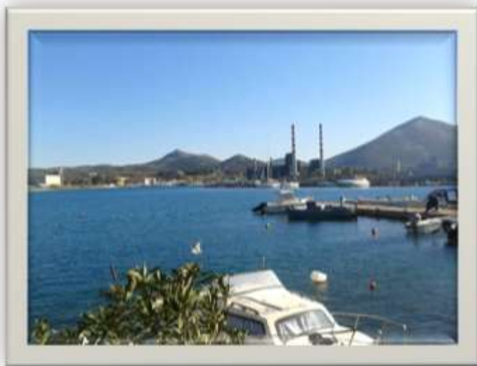
Το λιμάνι του Καράβου και το εργοστάσιο ηλεκτροπαραγωγής, όπως είναι σήμερα, 2020
