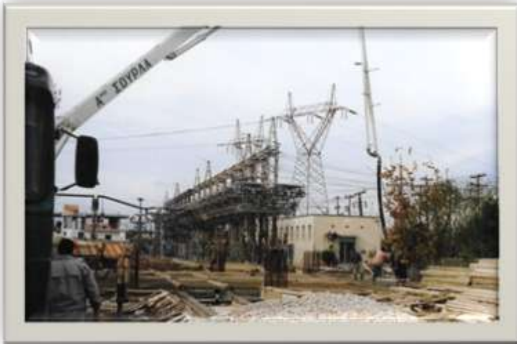
Κατασκευή κτιρίου επισκευής μετασχηματιστών στη Λάρισα, 1998
