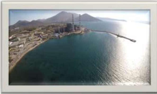
Το εργοστάσιο παραγωγής ηλεκτρικής ενέργειας στο Κάραβο, 2020
