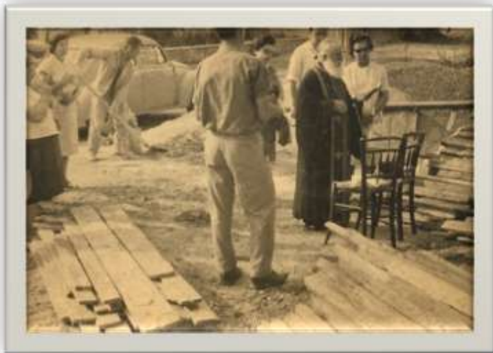
Η κατασκευή του σπιτιού στην οδό Λαμπάκη, τα εγκαίνια
