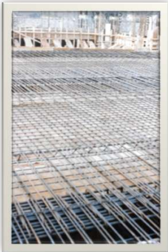
Κατασκευή κτιρίου επισκευής μετασχηματιστών στη Λάρισα, 1998
